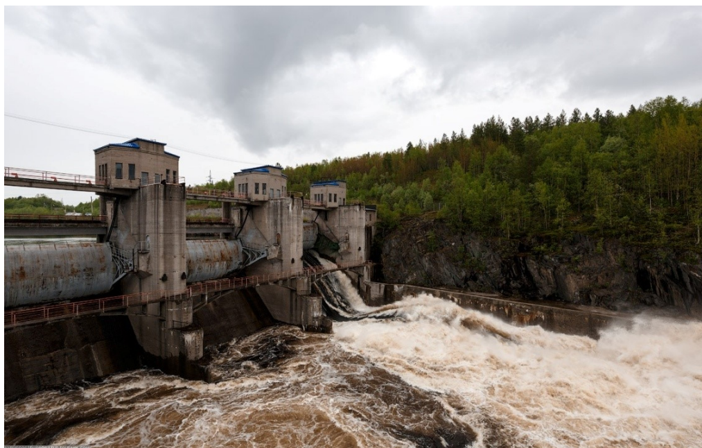
Рис. 12. Водосбросная плотина Нижне-Тулумской ГЭС [7] Fig. 12. Spillway dam of Nizhne-Tulomskaya hydroelectric station [7]
