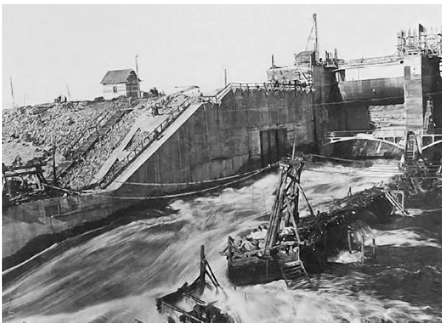
Рис. 5. Строительство водосброса Нижне-Тулумской ГЭС
