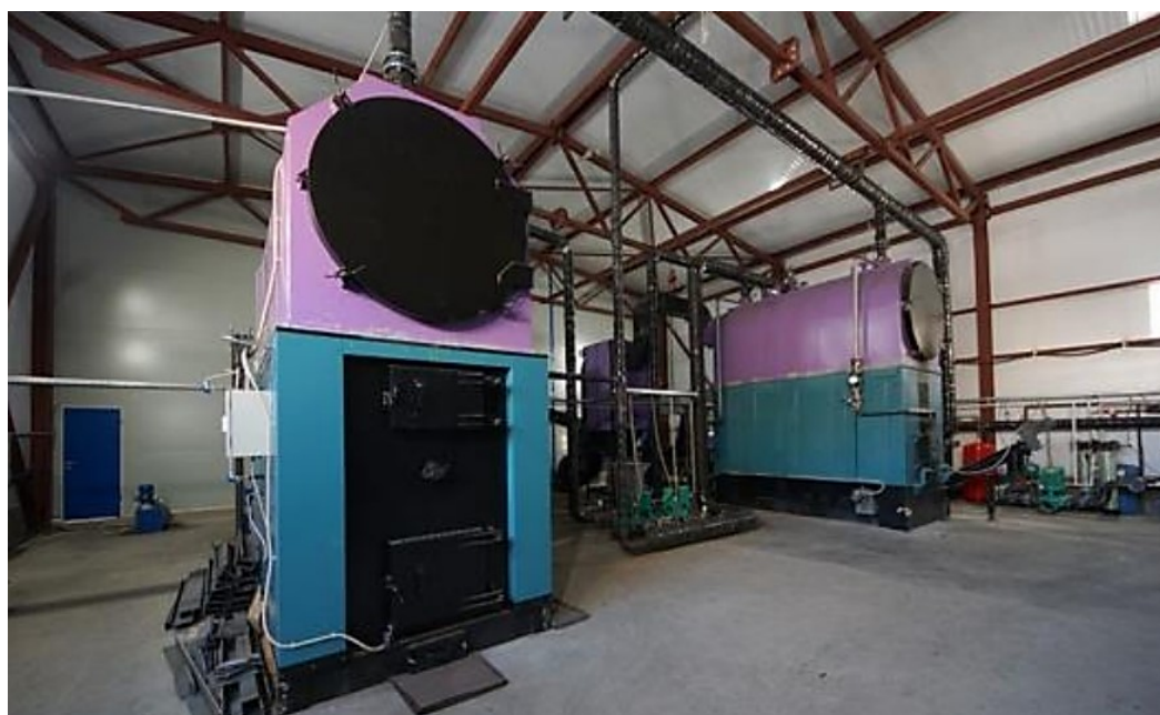
Рис. 3. Мультитопливный твердотопливный котел Fig. 3. Multi-fuel solid fuel boiler
