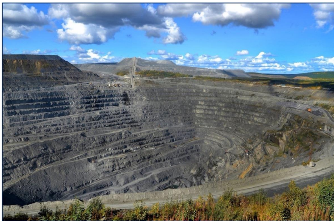
Рис. 4. Панорама Ковдорского горно-обогатительного комбината. Источник: фото пресс-службы АО «Ковдорский ГОК»
