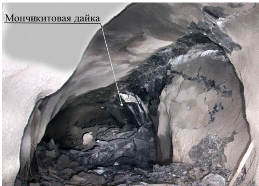
Рис. 16. Влияние жесткого включения на проявление внешних признаков удароопасности. Расвумчоррский рудник, материально-ходовой штрек-42
