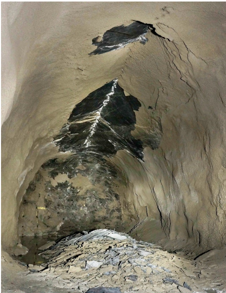
Рис. 6. Динамическое заколообразование по кровле. Расвумчоррский рудник, +310 м, квершлаг ВВС
