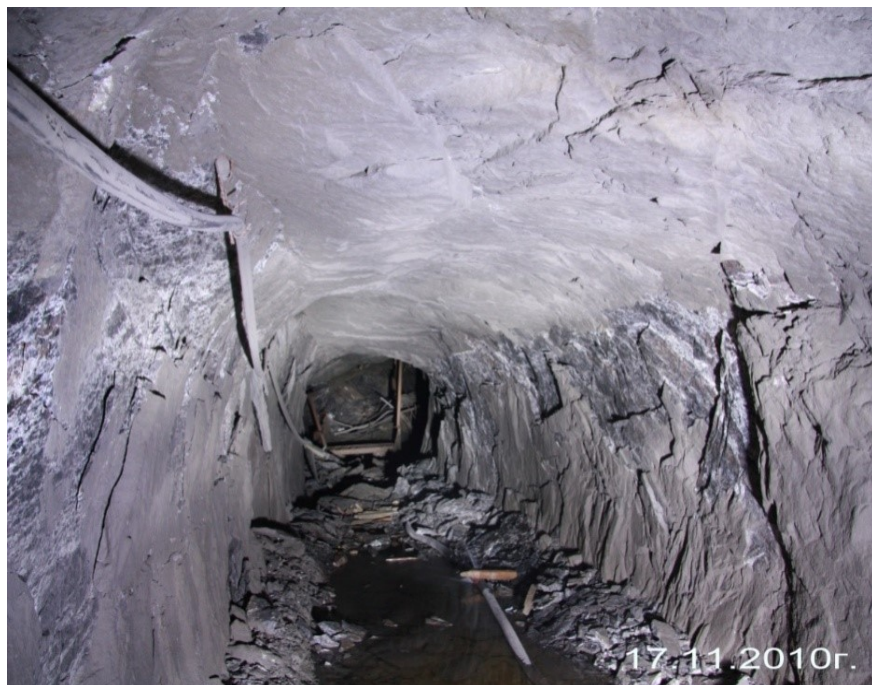
Рис. 10. Динамическое заколообразование по стенкам выработки. Расвумчорский рудник
