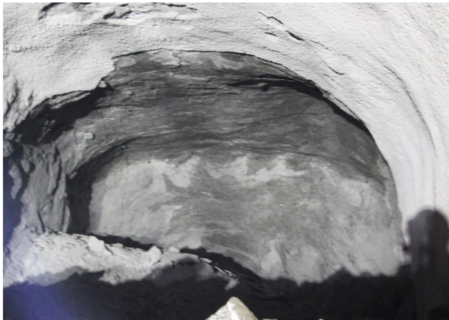
Рис. 7. Категория состояния Г. Динамическое заколообразование по кровле и ее сопряжениям со стенками при равнокомпонентном поле напряжений. Рудник «Олений ручей»
