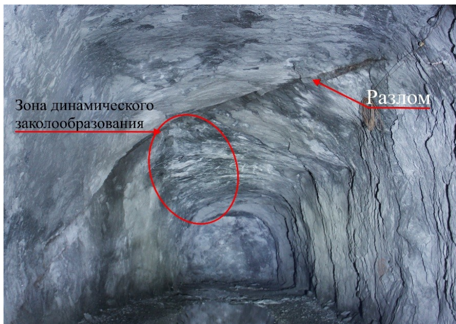
Рис. 15. Влияние разломной зоны на динамические проявления горного давления. Рудник «Олений ручей», полевой штрек +140
