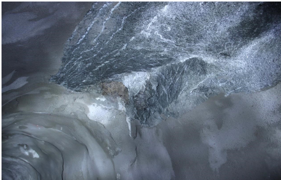
Рис. 11. Влияние отдельных трещин на перераспределение напряженного состояния массива. Рудник «Олений ручей»
