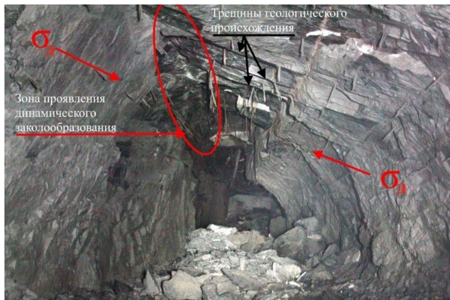
Рис. 14. Совпадение простирания основной системы трещин с направлением вектора действующих напряжений. Расвумчорский рудник, буро-доставочный штрек-12
