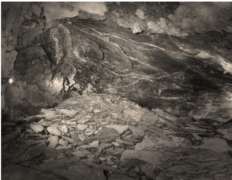
Рис. 9. Категория состояния Д. Интенсивное динамическое заколообразование по кровле, осложненное полого наклонными трещинами отдельности, вскрытыми по левой стенке. Расвумчоррский рудник
