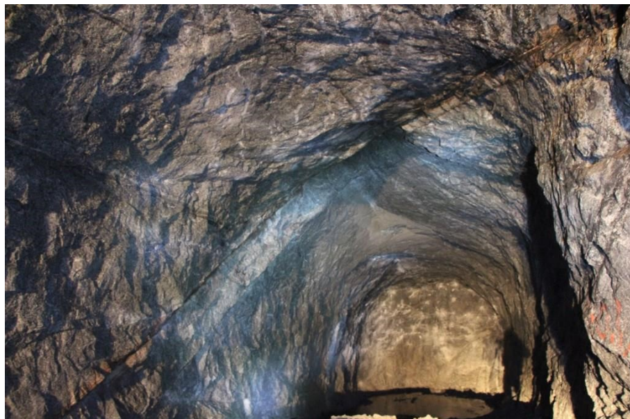
Рис. 13. Влияние разломных зон на перераспределение напряженного состояния массива. Рудник «Олений ручей»
