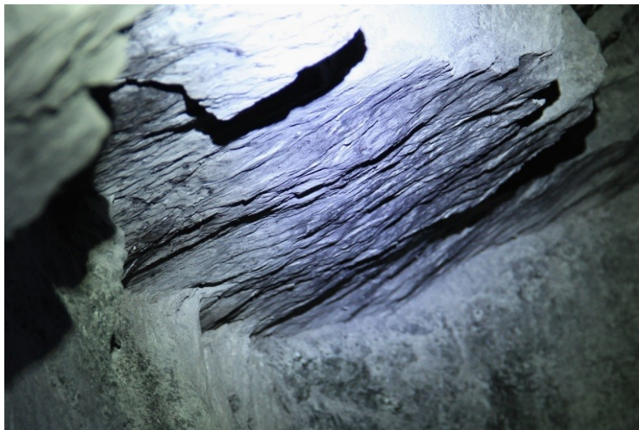
Рис. 22. Зеркало скольжения. Рудник «Олений ручей», автоуклон № 2
