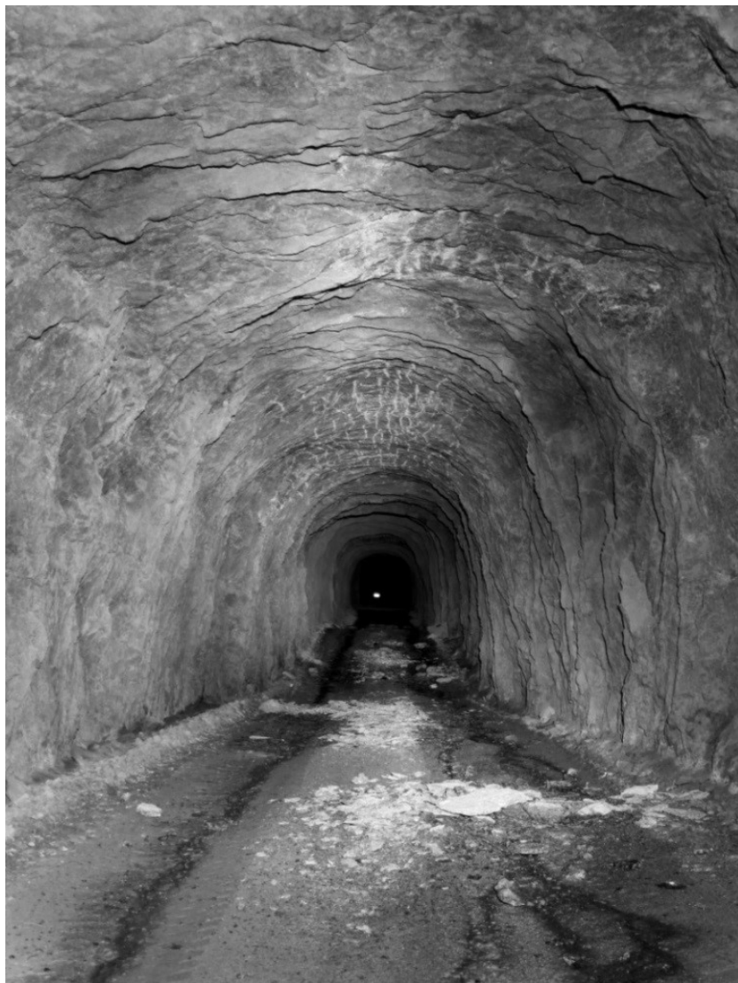
Рис. 17. Оценка безопасного маршрута прохождения выработки по обломкам породы на подошве. Рудник «Олений ручей», воздухоподводящий уклон
