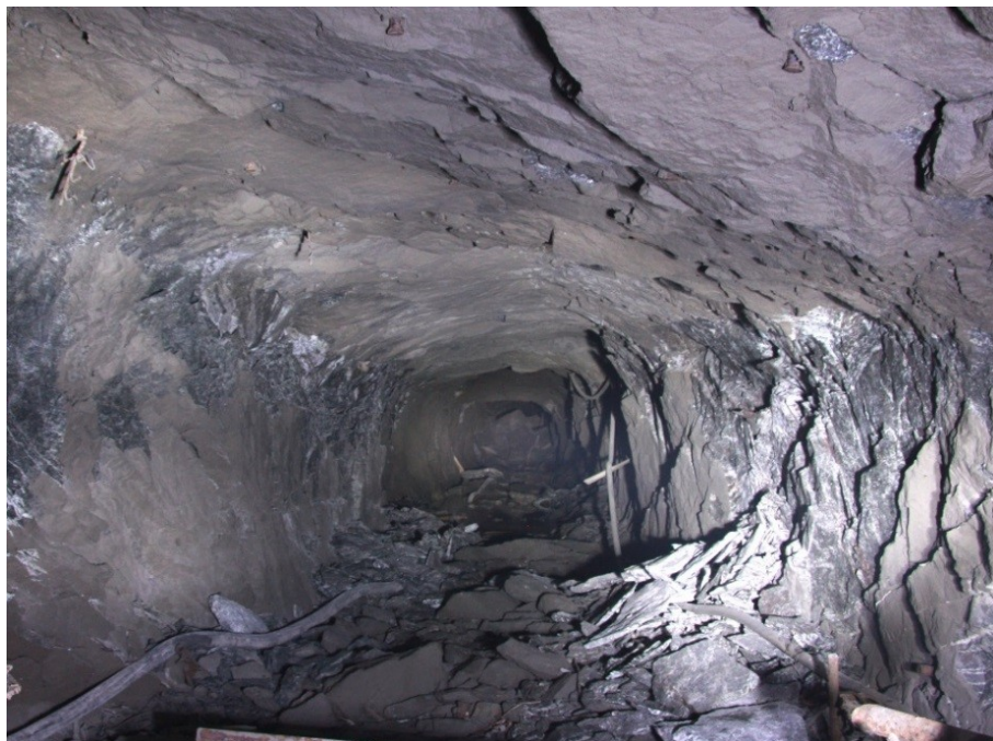
Рис. 9. Динамическое заколообразование по стенкам. Расвумчорский рудник, разведочный квершлаг 9
