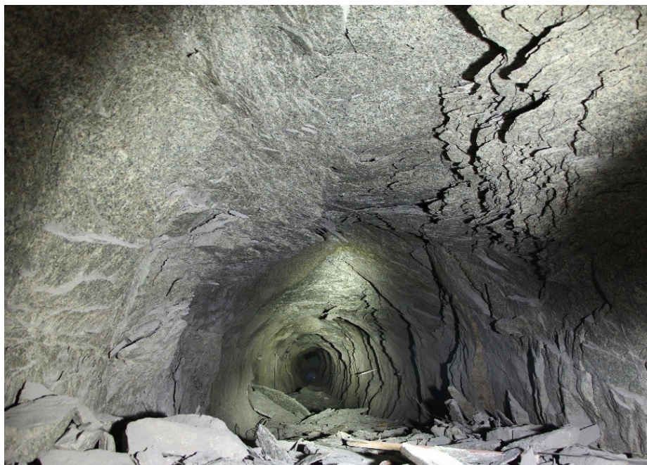
Рис. 11. Интенсивное динамическое заколообразование. Рудник «Карнасурт», восстающий-23-15
