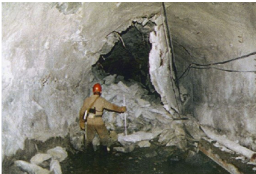
Рис. 4.8. Разрушение штреков на руднике «Умбозеро» (окончание): a — кровли откаточного штрека гор. + 230 м; b — кровли доставочного штрека гор. + 250 м
