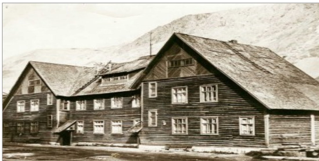
Здание Кольской базы АН СССР в пос. Кукисвумчорр (1936 г.)
