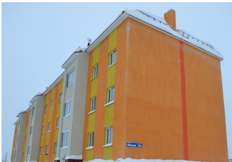
Рис. 53. Энергоэффективный дом в городе Лабытнанги
