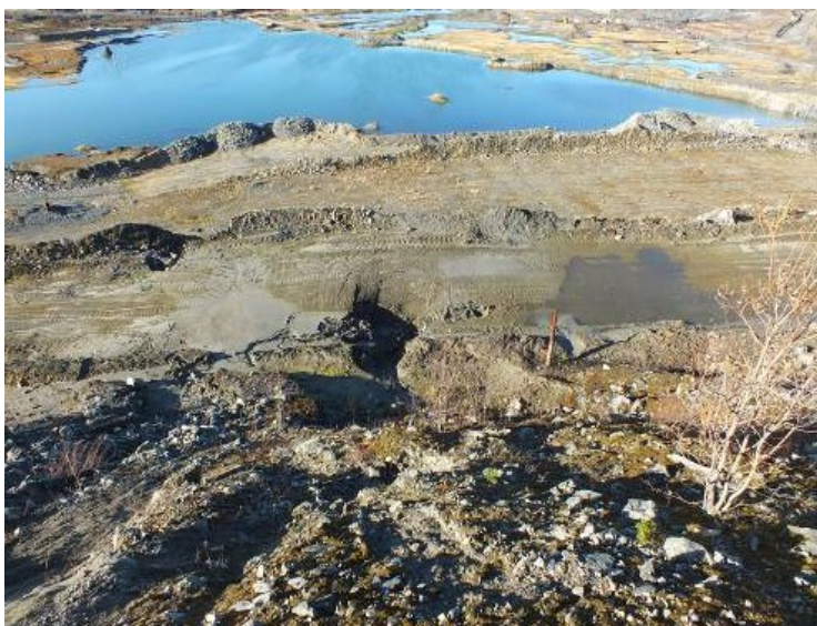
Рис. 4.11. Участок обследуемой ограждающей дамбы хвостохранилища (вид сверху)
